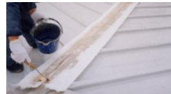
棟のFRPライニング
