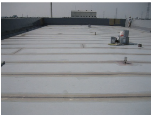
FRPライニング
