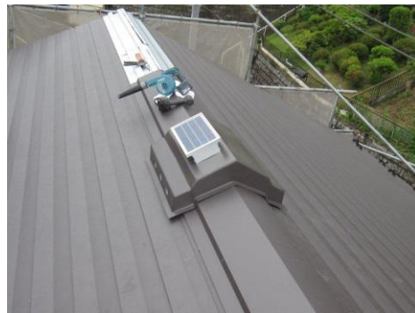
換気ユニット取付完了
