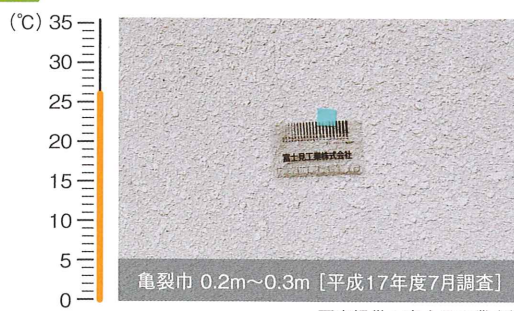
写真1 外気温26℃ 温度上昇による膨張
