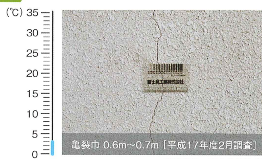
写真2 外気温3℃ 温度低下による収縮
