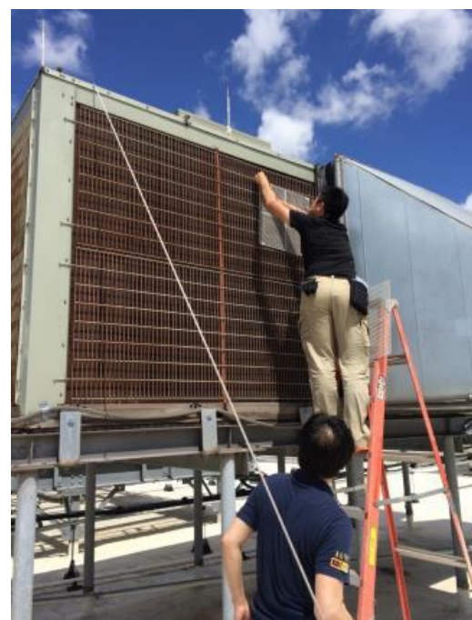
室外機M取り付け作業
