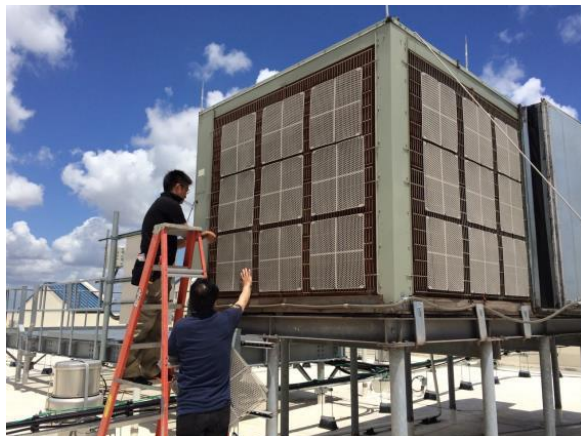
室外機取り付け完成
