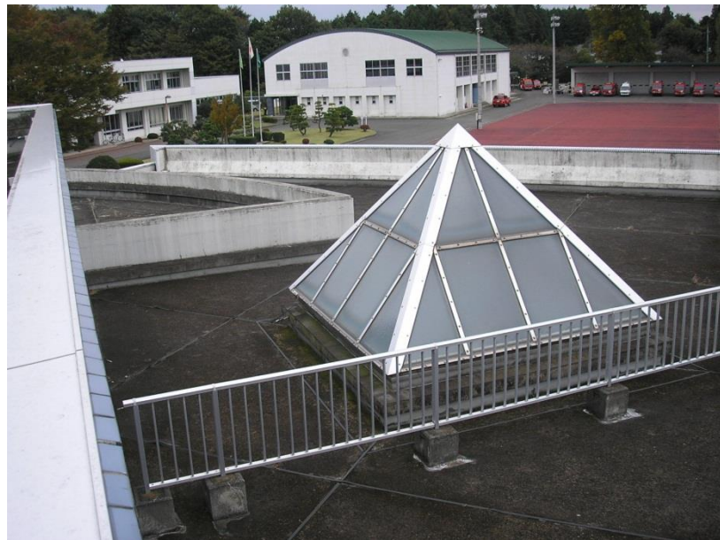
施工中(通気材+緩衝材+FRPシート)
