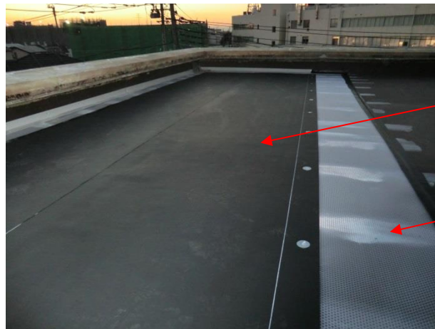
施工中(通気材敷きこみ)
